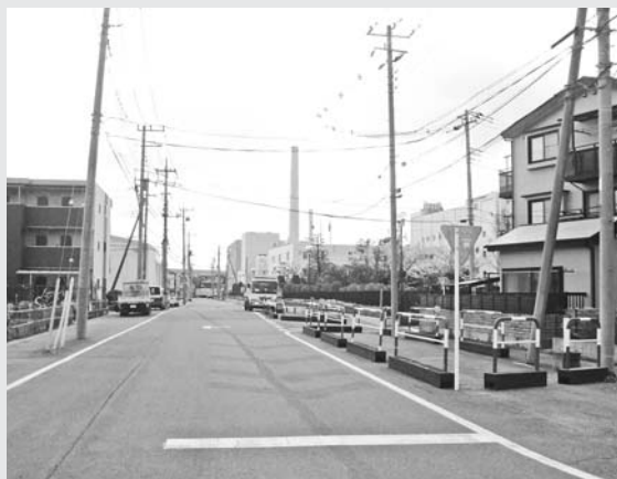
新設舗装する錦町松原線
