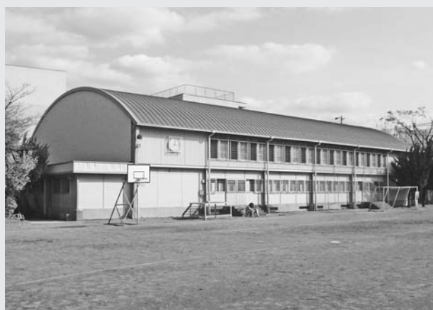
耐震補強工事が行われる中央東小体育館
