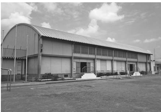
耐震補強工事と床などの改修工事が行われる北小体育館
