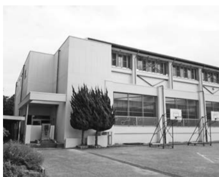
耐震化が完了した塚越小体育館
