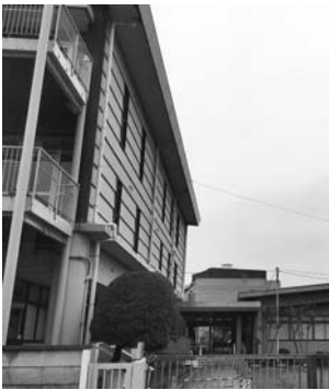
老朽化対策が求められる松原会館
