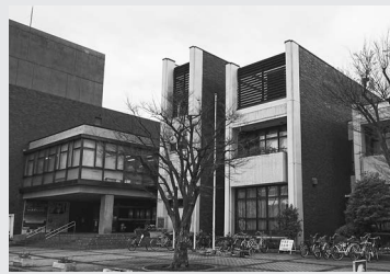
耐震補強工事が行われる市民会館等
